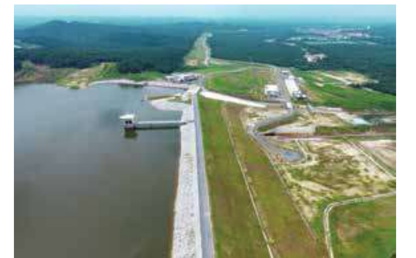
Seluyut Dam in Kota Tinggi, Johor
